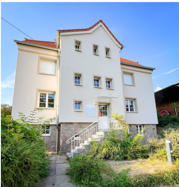
Abb. 4: Bürogebäude der ZEPP
